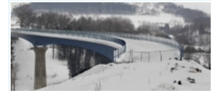
Still ruht der Bau: Die Bitumendecke für den Viadukt in Markersbach kann bei so viel Schnee nicht aufgezogen werden.
